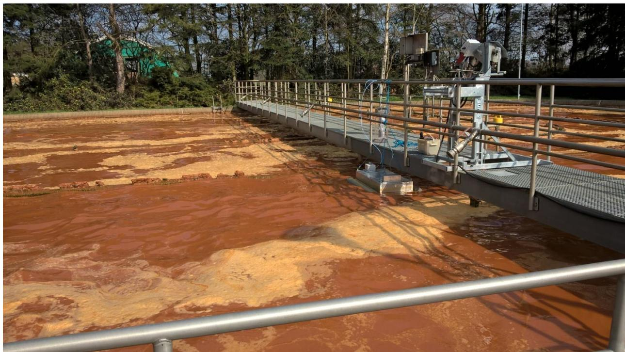
Abbildung 4-1: Probenahme auf dem Belebungsbecken
